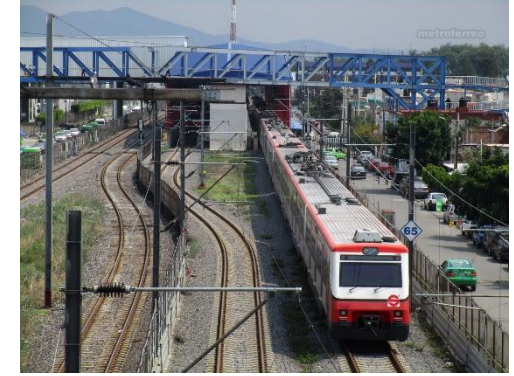
Tren suburbano (catenaria 25kV 60Hz)
